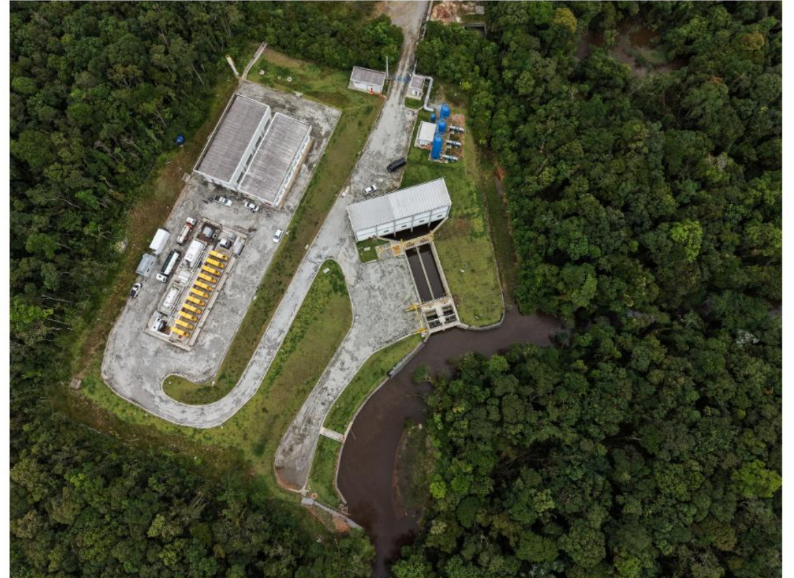
Vista aérea da obra de transferência do Itapanhaú, incluindo sistema de captação, bombas e geradores. Investimento total foi de R$ 300 milhões, segundo a companhia.
