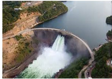
Kariba Dam Spilling
